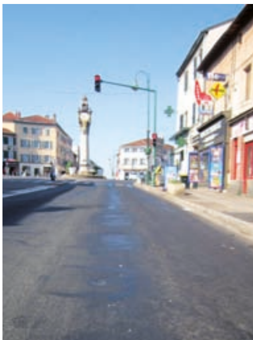
Figure 24 : ressuage (remontée de bitume en excès en surface, notamment par temps chaud). Photo Tassin-la-Demi-Lune - Victor Hugo - Laboratoire Voirie - Métropole de Lyon.
