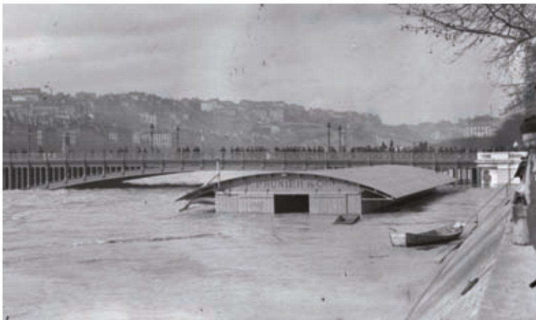
Figure 13 : inondation de la Saône à Lyon : montée des eaux quai Saint-Antoine, 20 mai 1856. Source : Archives municipales de Lyon.
